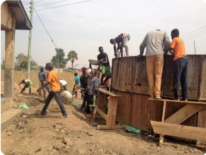
Figuur 6 Eén van de 2 regenwatertanks in aanbouw.
